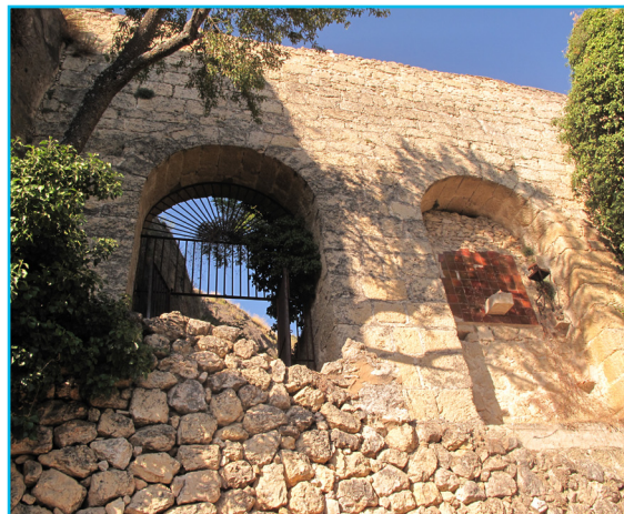
Segundo Acueducto de la Conducción de la Cueva del Fraile (Cuenca)
